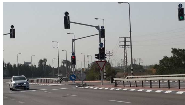
איור 5.18: דוגמאות להתקנת מעקות הבטיחות על גבי מפרדה בקרבת צומת מרומזר
